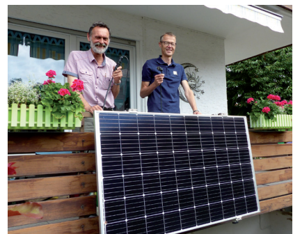
Peter Strnad (MER) und Klaus Härterich vom Energieteam am Fachzentrum für Energie und Landtechnik Triesdorf nehmen ein Stecker-Solargerät in Betrieb
